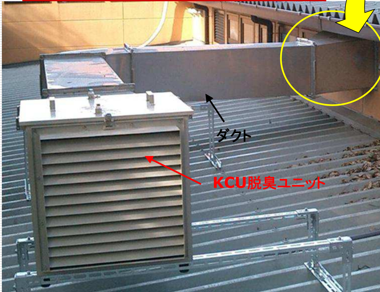
写2 ダクト・KCU脱臭ユニット(施工後)
