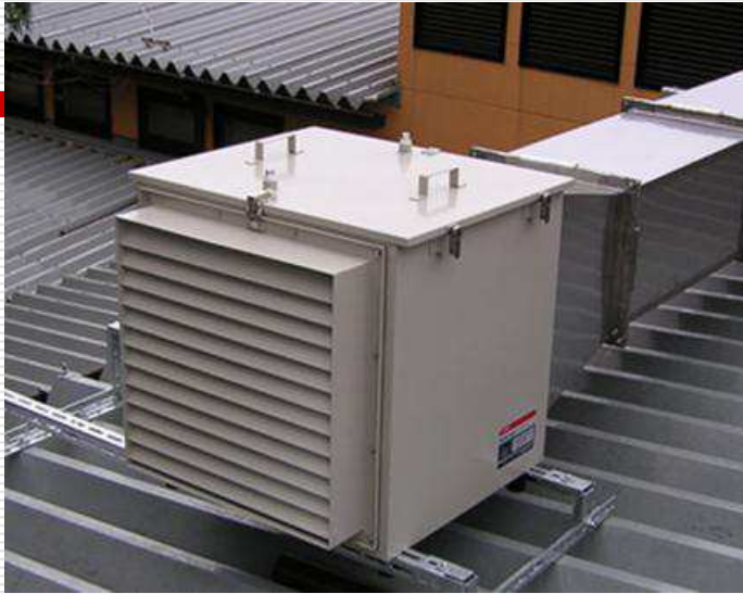
写真1 KCUユニット設置
