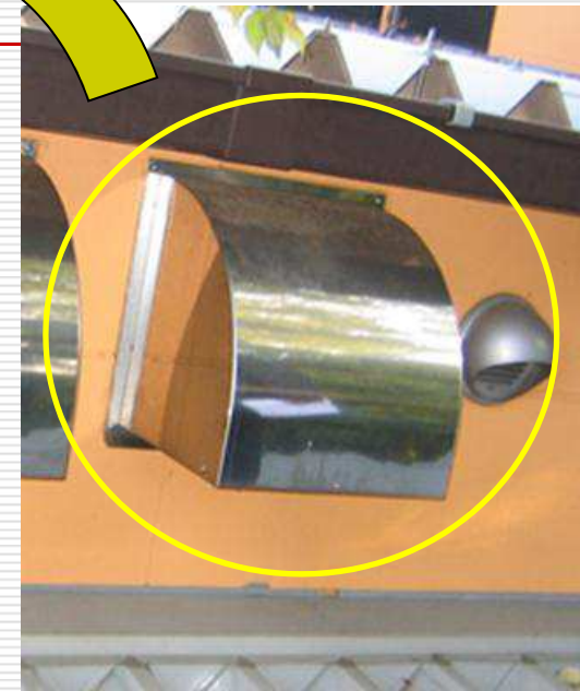
写1 排出口(施工前)
